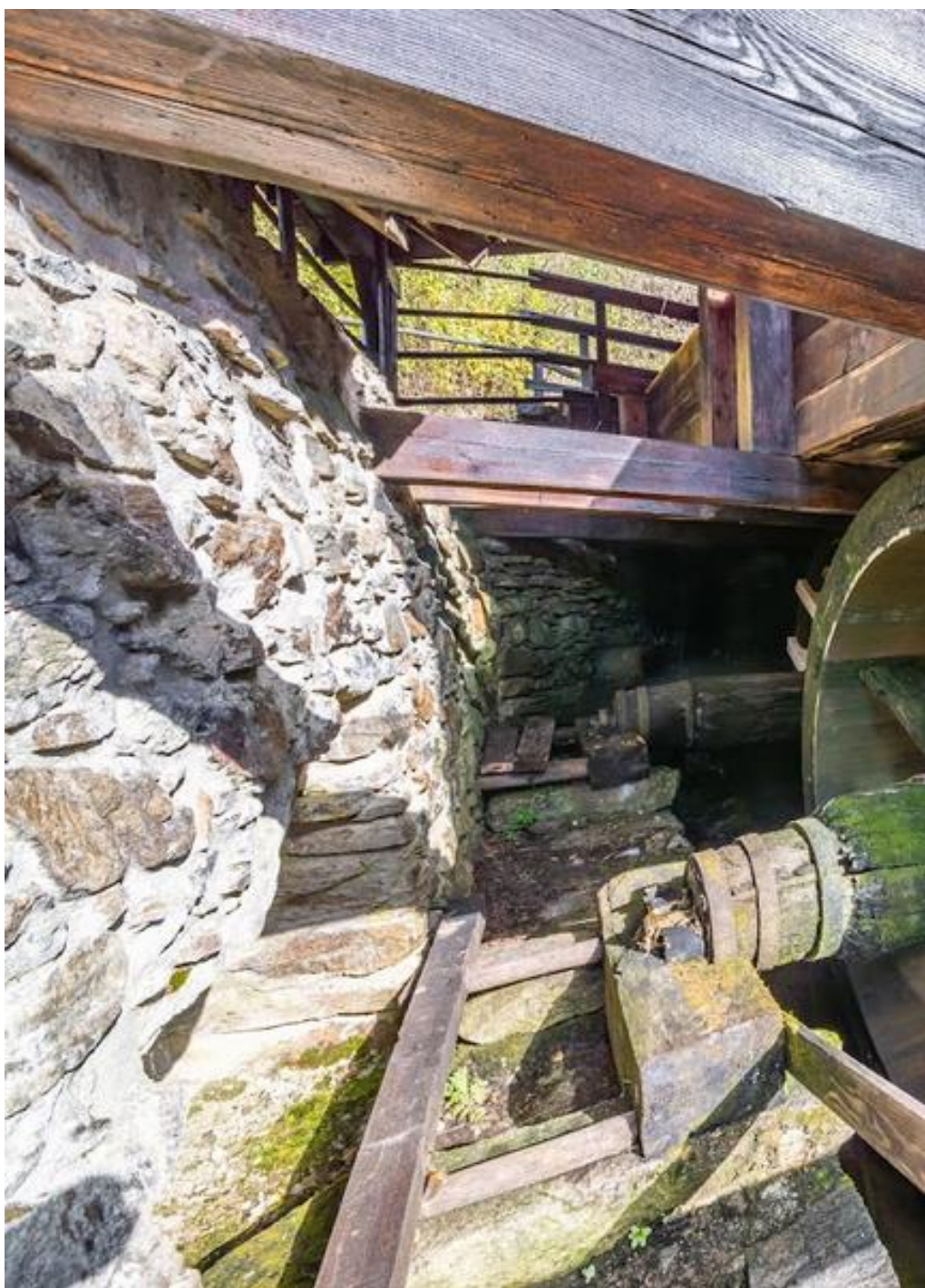
Abb.7: Mlýn v klášterním areálu ve Žďáru nad Sázavou Mühle in der Klosterlandschaft von Žďár nad Sázavou
